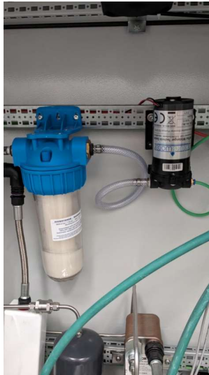
Ilustración 13: prefiltro y bomba de alimentación
