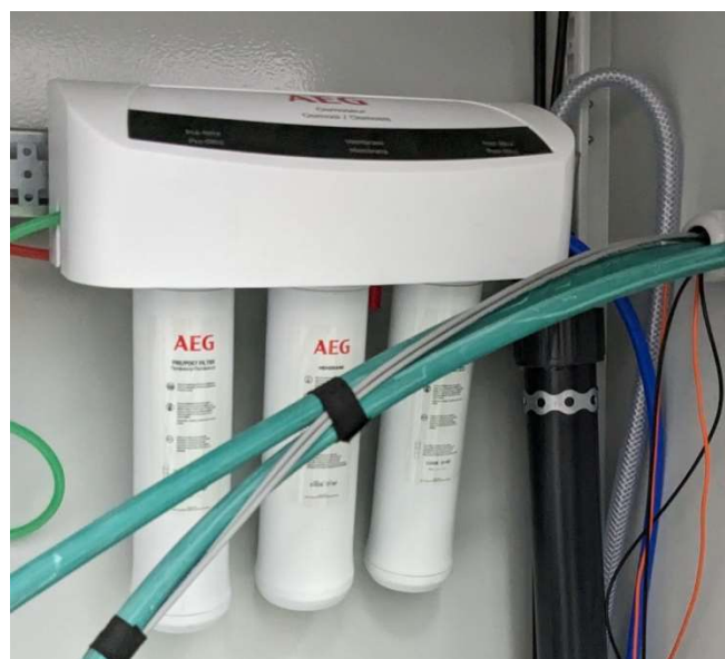
Ilustración 14: sistema AEG de desionización
